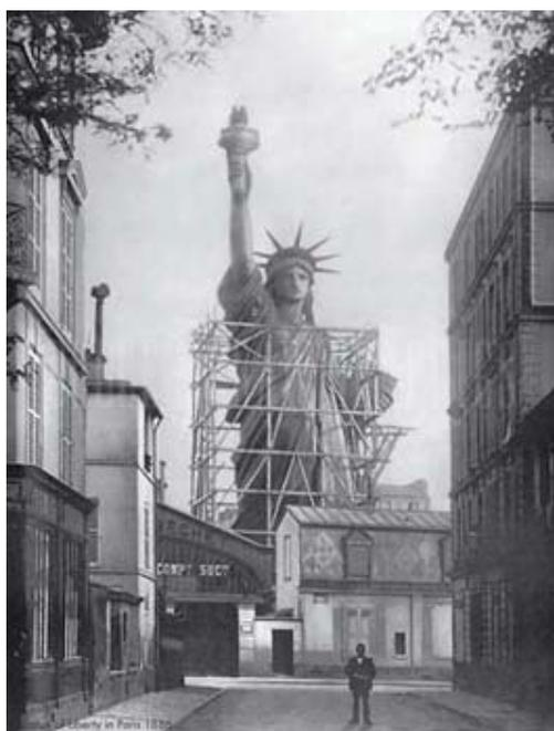
Auguste Bartholdi reçoit le concours d'Eugène Viollet-le-Duc. L'architecte-ingénieur prescrit une peau composée de plaques de cuivre modelées par martelage sur des formes en plâtre. L'ensemble doit être monté sur une armature métallique, stabilisée par un remplissage en sable.
