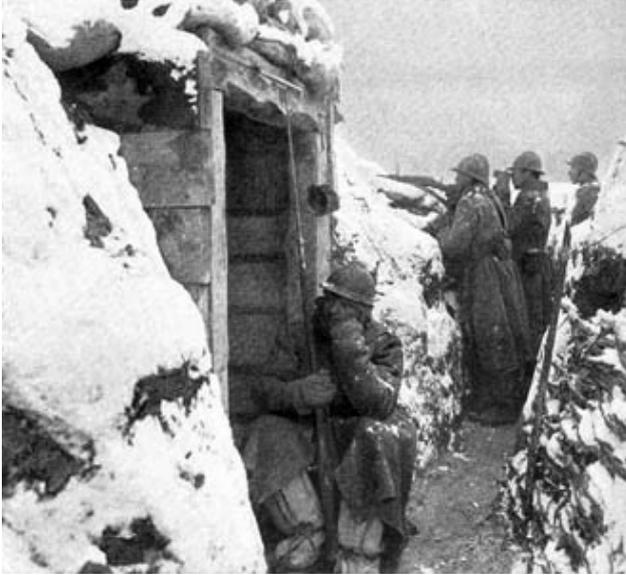
A espace régulier, des abris couverts dit "abris léger" ou "sapes" sont aménagés. Ils peuvent abriter 6 à 8 hommes. Ils doivent être creusés sous plusieurs mètres de terre et renforcés de rondins et de poutres de bois afin de pouvoir résister à un bombardement de petits calibres tels que les 77 et 105 mm.
