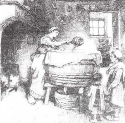
*Utilisation du bugeoir ou cuvier*Le cuvier doit être plus large que haut pour que l'eau chaude n'ai pas un trop grand espace à traverser. On met dans le fond du cuvier trois ou quatre torchons dont on fait sortir les cornes par le goulot. Sur l'ouverture du goulot, on place l'os d'une machoire inférieure de cochon...elle sert à empêcher les torchons de s'affaisser.
