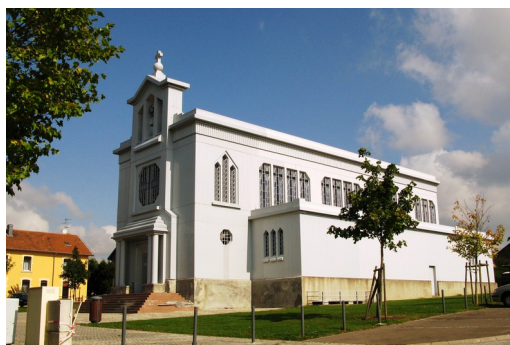
Après la rénovation
